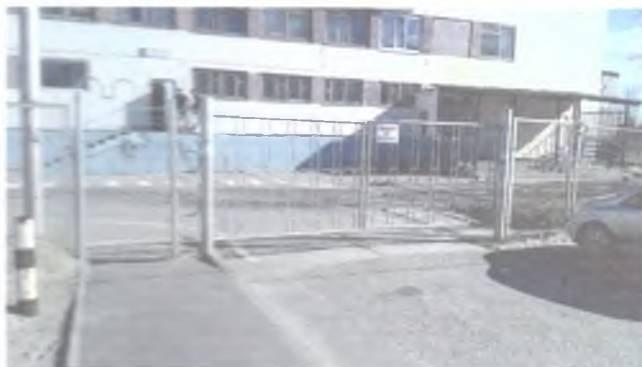
1.1 общий вид входа
