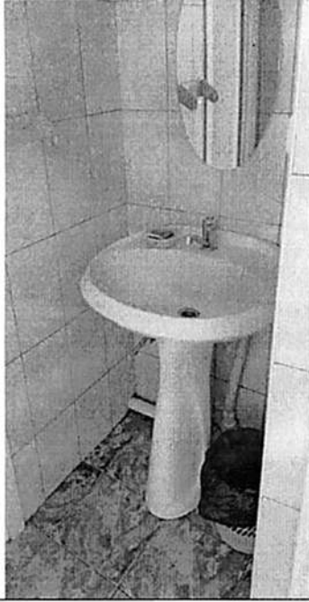
Фото №24 (туалетная комната 2 корпус)
