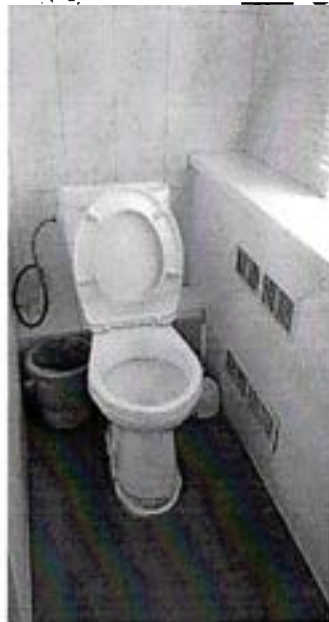
Фото №16 (туалетная комната 1 корпус)
