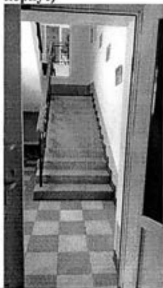
Фото №13 (лестница внутри здания 1 корпус)
